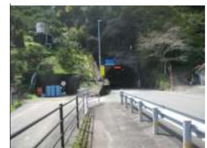
久保宇津トンネル
