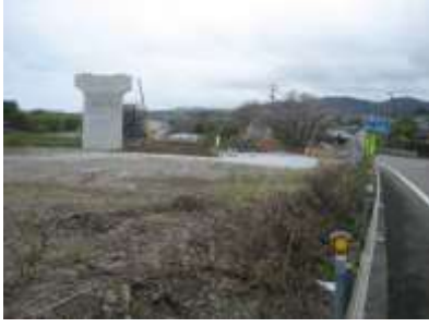
高速道路工事中 国道へ迂回
