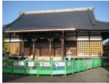
吉祥寺 本堂(工事中)
