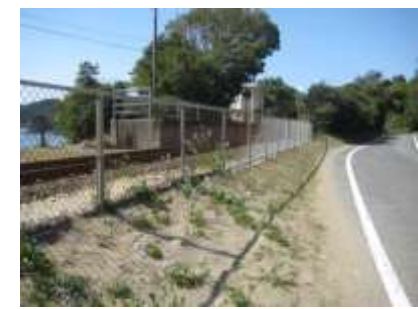
田井ノ浜駅付近
