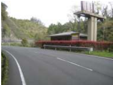
中筋ダム警報所
