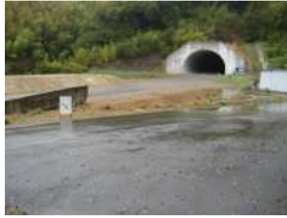
四国縦断自動車道工事中
