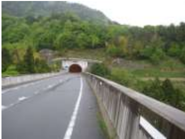
はらいがわトンネル
