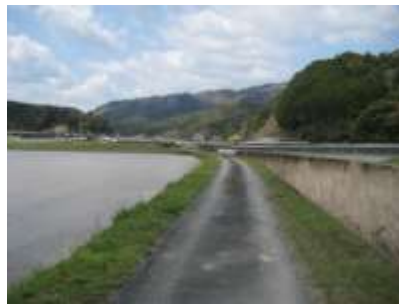
先の橋から県道へ合流
