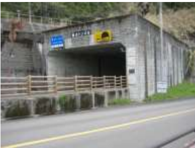
横浜トンネル
