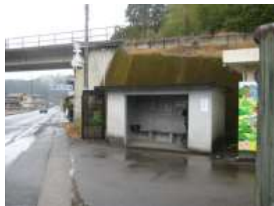
浅川駅 待合室 トイレ有り
