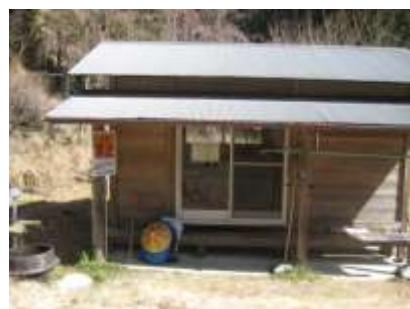
柳水庵下の休憩小屋
