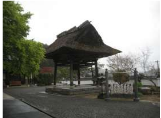
佛木寺 茅葺の鐘楼
