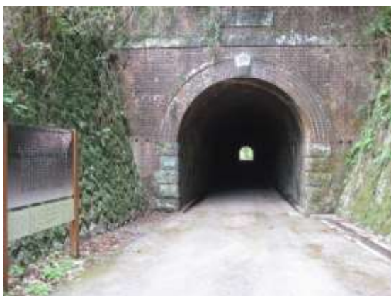
熊井トンネル
