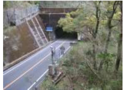
片坂第一、第二トンネルの間に入る
