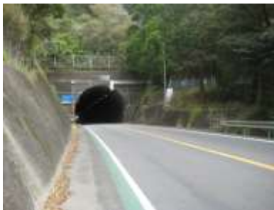
井の岬トンネル
