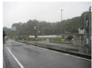
新しく大山トンネルが出来ている
