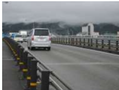
安芸川橋を渡り市街地へ
