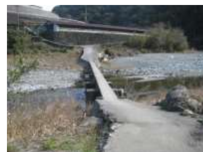
潜水橋を渡り県道へ
