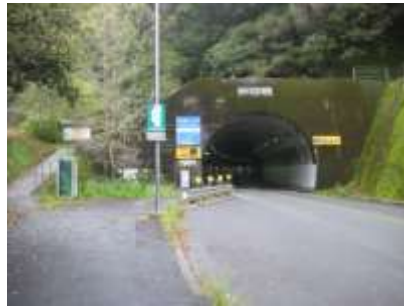
松尾トンネル脇から遍路道へ
