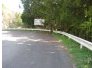
ガードレールの間から下る
