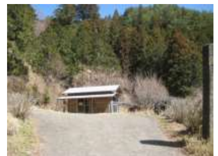
柳水庵下の休憩小屋
