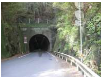
浦の内トンネル
