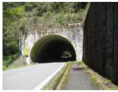
落合トンネル
