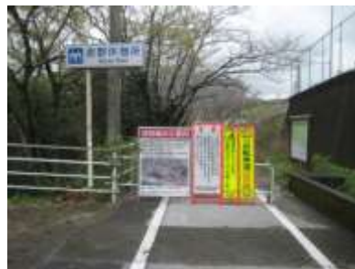
高速工事で迂回
