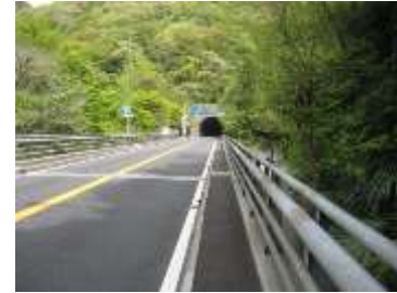
境目トンネル
