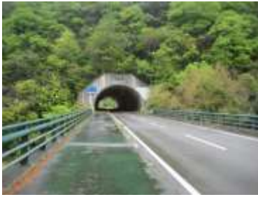
岩野トンネル
