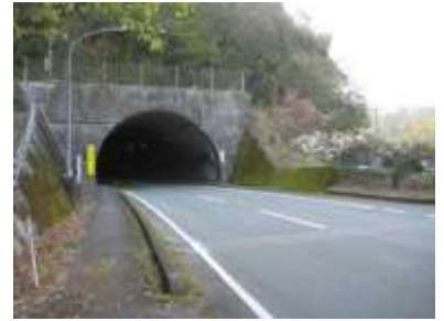
長岡山トンネル
