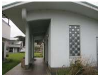
以布利ジンベエ広場のトイレ
